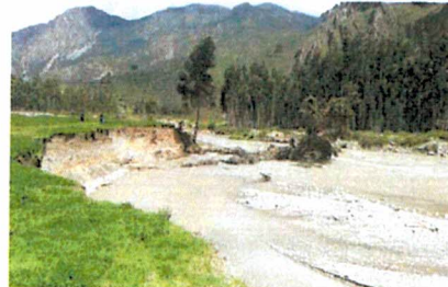
EL CAUCE DEL RIO VIENE EROSIONANDO LAS ÁREAS QUE SE PROTEGE LA CONSTRUCCION
